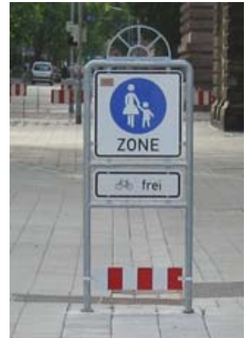
Bild 49: Beispiel für Tastkante und visuelle Markierung eines Schildes
